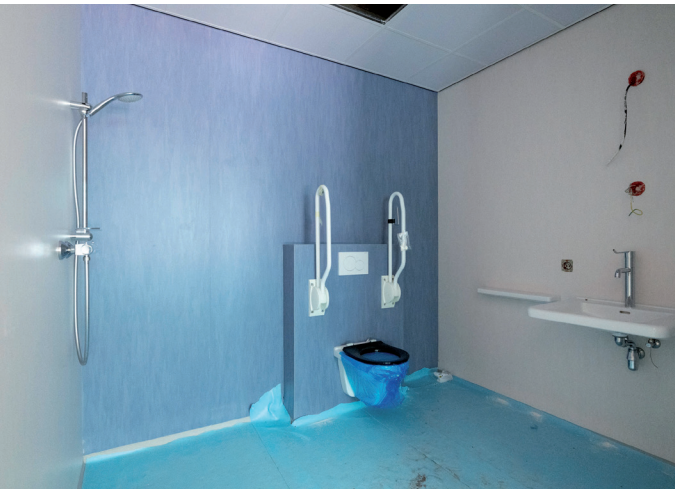
Zorgstudio in de Balticstaete in aanbouw
