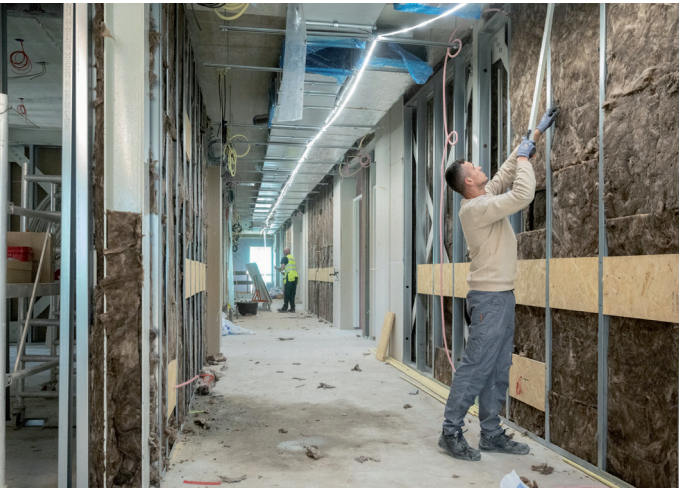
Ook binnen vorderen de werkzaamheden
